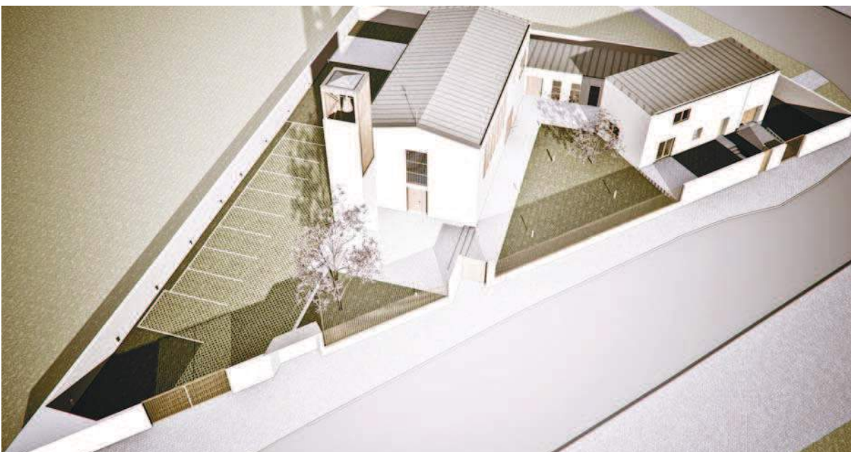
A madártávlat mutatja az egységes kishajlású Rheinzink tetőket
