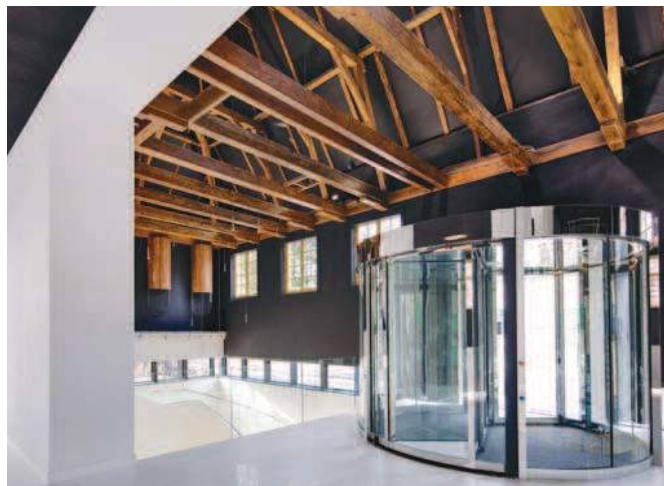
A régi szerkezetek megmaradtak, egy méterrel megemelve
