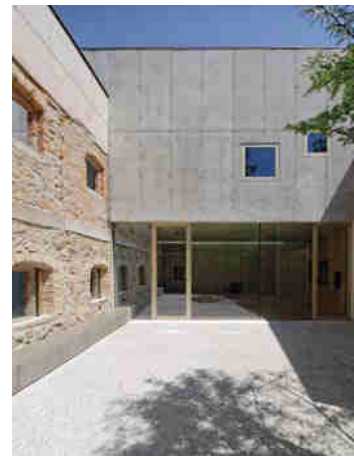
A történeti falazatot átható vasbeton kubus a belsőudvar felől
