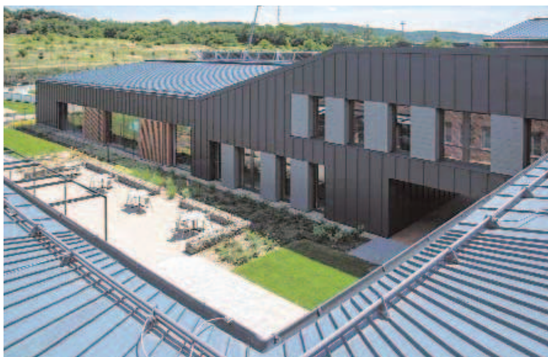
Az új épületszárny alumínium-burkolatú homlokzata a meglévő épület felől nézve
