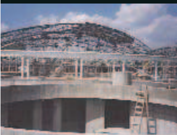
Az építkezés képei 1994-ből
