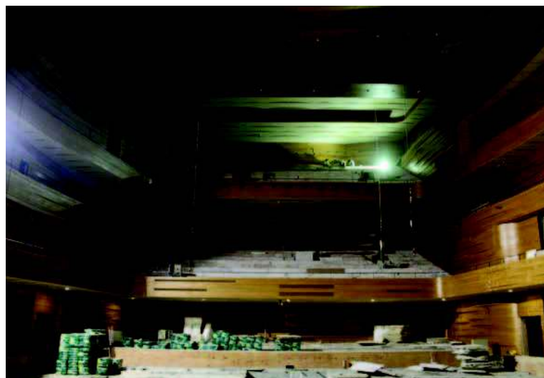
A színházterem íves karzatai és a hullámzó faburkolatok biztosítják a kiváló akusztikai minőséget (látványterv és építés közbeni állapot)
