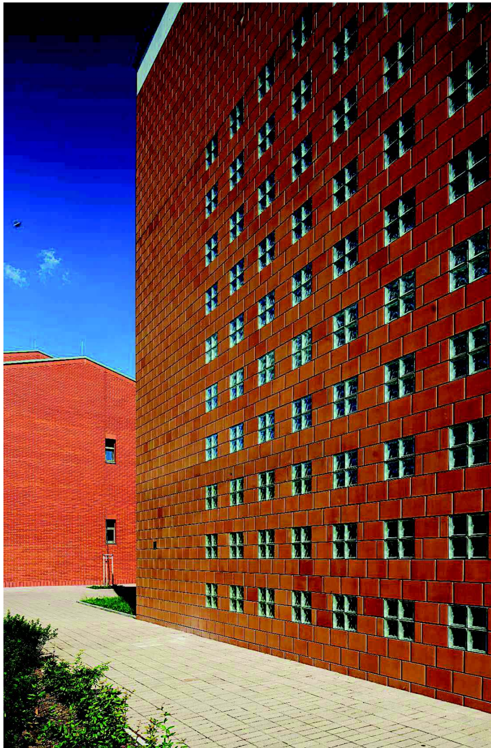
Északi homlokzat részlet, az üveg-tégla bevilágítás a belső növényfalat szolgálja
