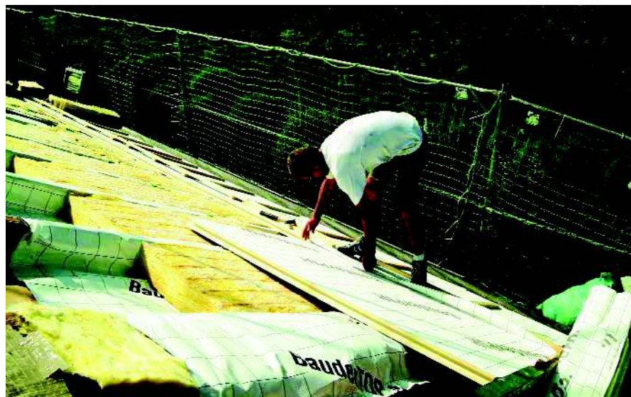
[1] Szarufák feletti rendszer fektetése
