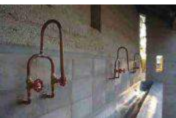
Helyszínen szerkesztett kemping-csapok a borteraszt oldalsó falánál
