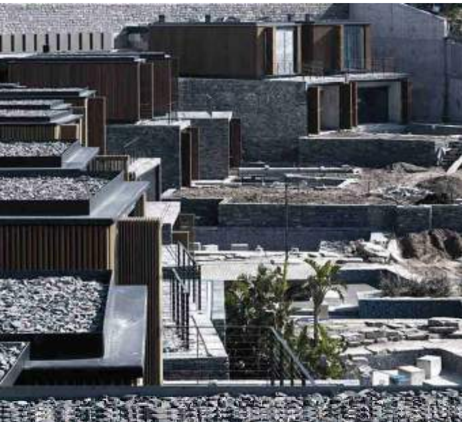
Nehézkedés és feloldása. A földszint kőtalapzatán favázas felépítmények sorakoznak
