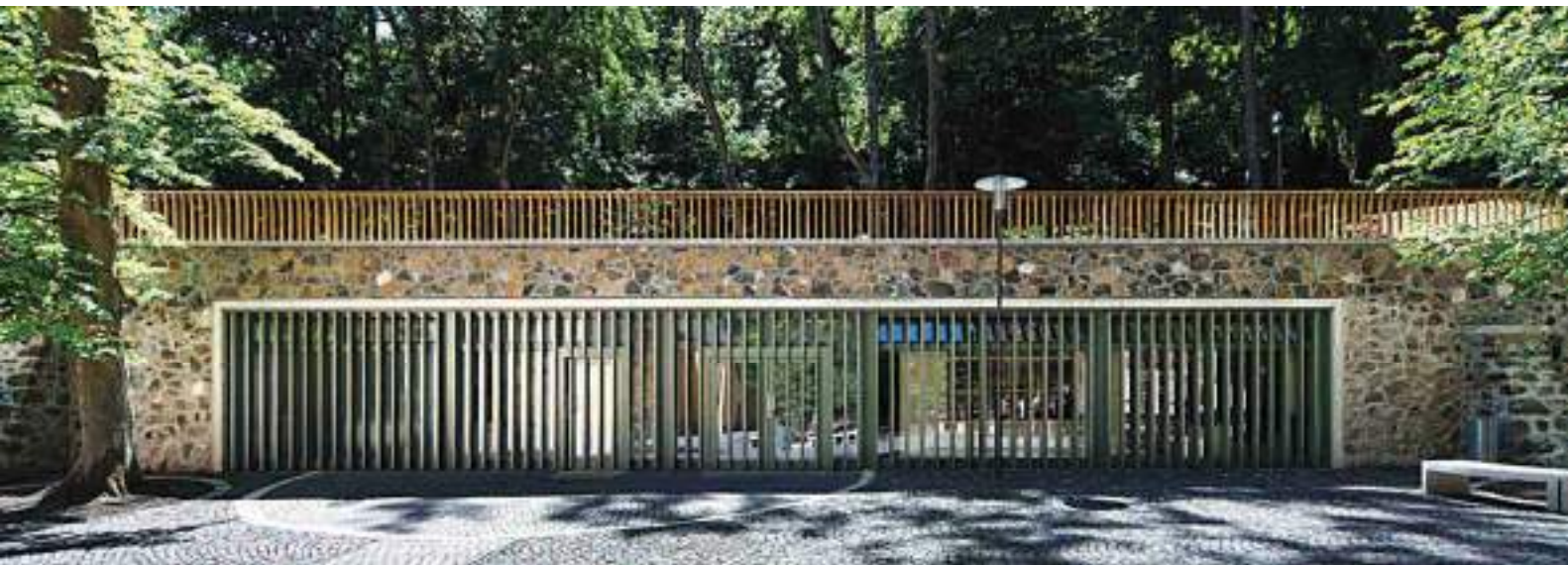
A megújított támfalban kialakított kegytárgybolt
