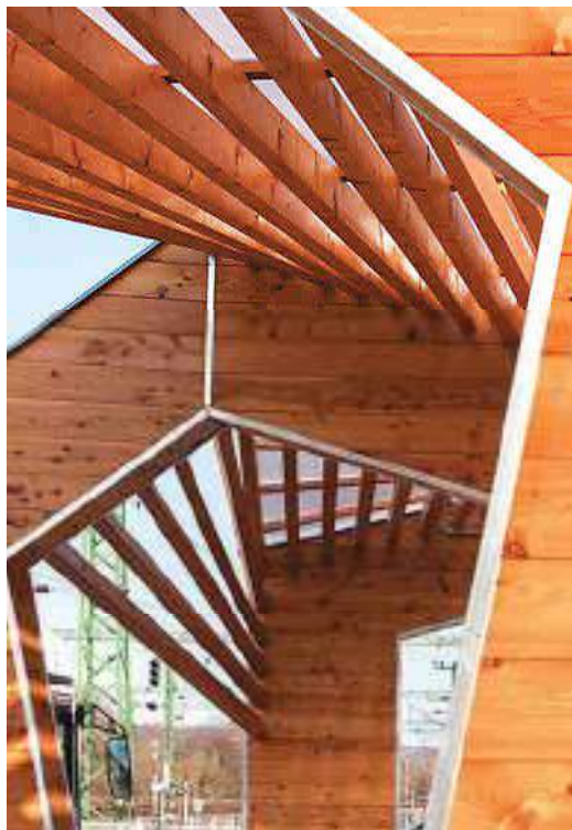
Csavaros látvány, játék a szögekkel – a tartók eltérő alakjából adódó hiperbolikus felületeket hosszirányú szelemenek rajzolják ki. A tető átlátszó fedést kapott, a tartók szárán lefordulva véd a szélől és naptól egyaránt
