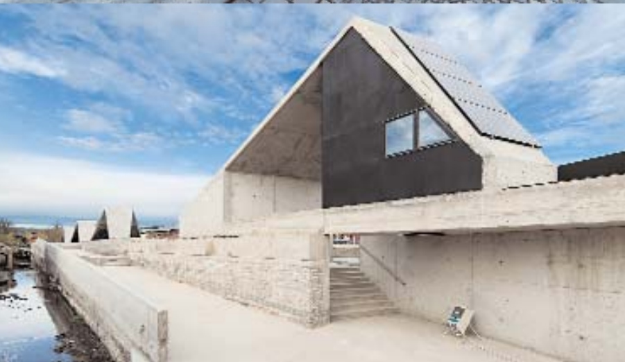
A patakmeder mentén felgyűrődő betonelemek célja részben formai, részben funkcionális. Az építménysor a múzeum és a skanzen területét formai értelemben is egymáshoz köti, miközben néhány szabadterei pavilonfunkcióknak, így a büfének is helyet ad
