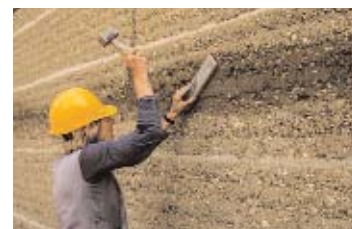
A hézagok eldolgozása (a fal homogenizálása)
