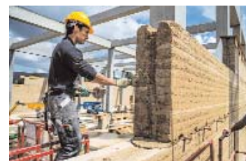
A vályogfal elemek elhelyezése
