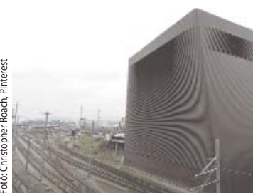
Central Signal Box, Bazel, Svájc
