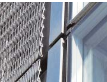
Homlokzatrészlet, huzalszövet-háló, Dominique Perrault
