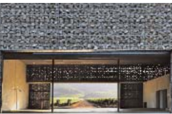
Dominus borászat, homlokzati részlet a helyi kövekkel töltött gabionokkal. Napa völgy, Kalifornia, Egyesült Államok
