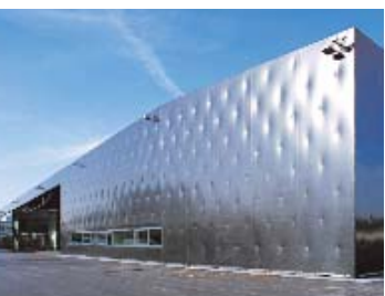
Városüzemeltető telephely homlokzatrészlete, „kárpitós gombokkal” rögzített tetőfólia, Amsfelden, Ausztria, Caramel Architekten
