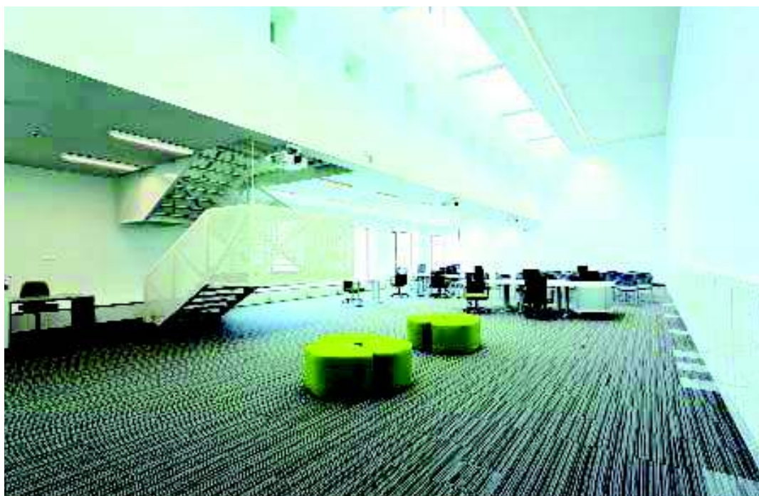
Az Informatórium belső tere: a teret hosszirányú faltartó hidalja át
