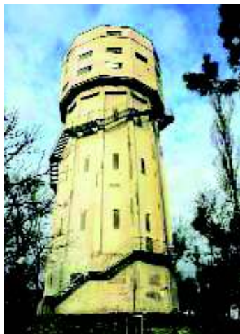
Víztornykülső az átalakítás után...
