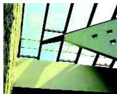
A közlekedőmag szobrászi konzolja tartja az üvegfödémeket
