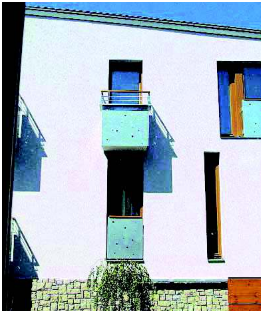
A mellvédek 5 mm vastag lyuggatott horganyzott lemezből készültek
