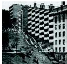
Lakóház a Tabán szélén, építész: Schmidt Lajos (1964)
