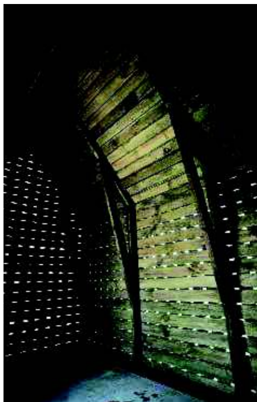
Belső tér tartósszerkezettel
