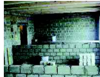
Lakószobák közötti vályogfalak fémmelevítés és cement nélkül
