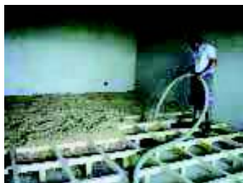
Füjt fagyapot szigetelés a hajópado alatt
