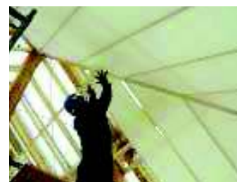
Belső felület. A szövetet tépőzárral erősítették a favázra, így később eltávolítható (mosható). Erre a mérések miatt volt szükség
