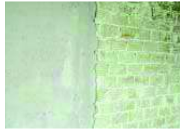
Gépi vakolásra is alkalmas vályogvakolat a vályogfalazaton
