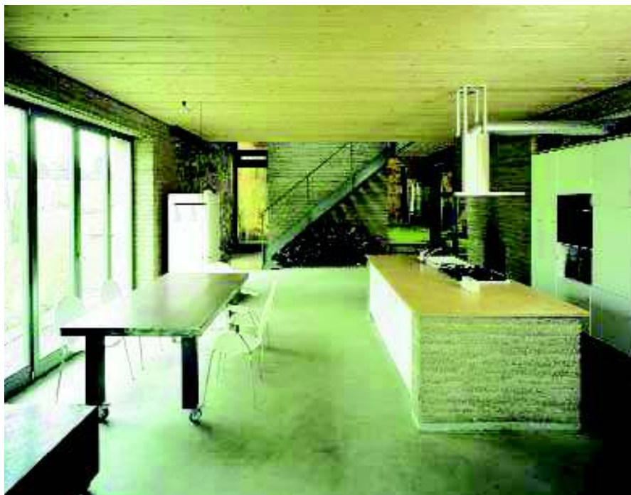
A lakókonyhában a pult is vert vályog
