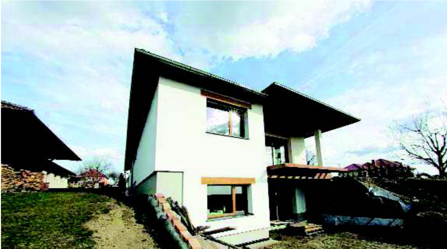
A kilátás felé tájolt nyugati homlokzat
