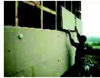
Lágyfarost burkolat készítése a hőhíd megszakítás fa tartóvázon
