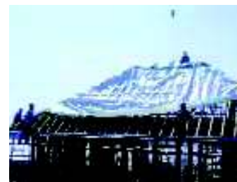
A külső vászon elhelyezése. A teljes felületet egy darabban kellett kifejteni
