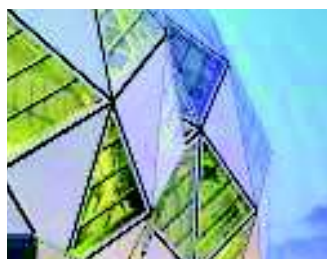
A helyszíni méretre szabással és a körkeresztmetszetű vázszervényekbe való beépítéssel a kivitelező minőségi munkát végzett
